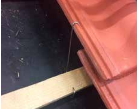
Bild 11. Montering av Easy Clip, placeras så att både undre och övre pannan låses med samma clips.
