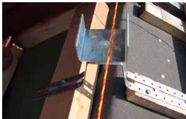
Monteringsbild 4. Montera ett snöre i centrum av de båda nockhållarna som placerats på taket. Montera dit resterande nockhållare som nu får rätt höjd och även görnocken absolut rak. Bilden visar höger sida råspontmontage, vänster sida lätt undertak.
