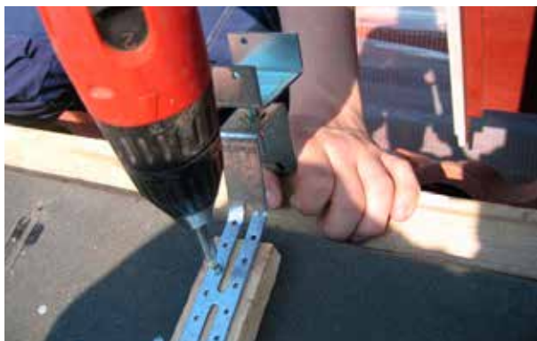
Monteringsbild 3. Skruva fast en nockhållare i vardera ändan av nockbrädan och justera in i rätt höjd.
