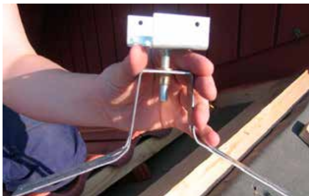
Monteringsbild 2. Böcka U-benen så du erhåller rätt höjd, finjustering kan du göra senare. Tänk på att U-benen skall ligga ovan bärläkt på lätt undertak och ovan ströläkt vid traditionellt tak (råspont).
